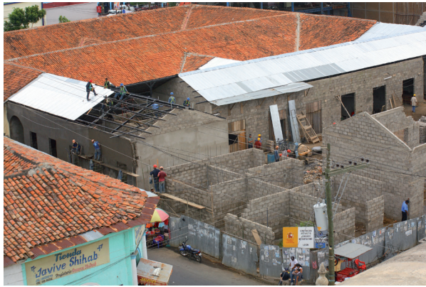
Construcción 2ª fase del Centro Comercial Metropolitano por alumnos de la Escuela Taller de León.
